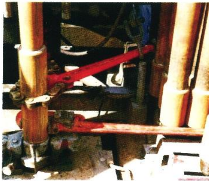
BW200とP1200でのロッド切り作業の様子
